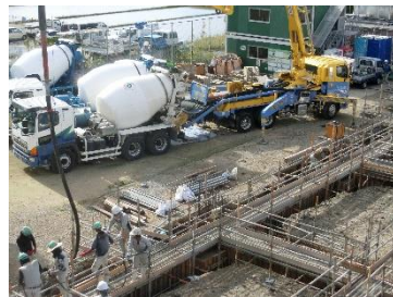
【8月頃の工事の様子】
